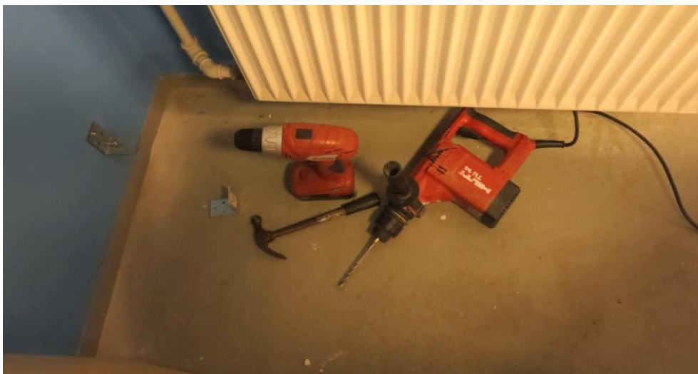
Det er stærke sager der skal til, når først banebørsterne går i gang med at bore huller med borehammer.
